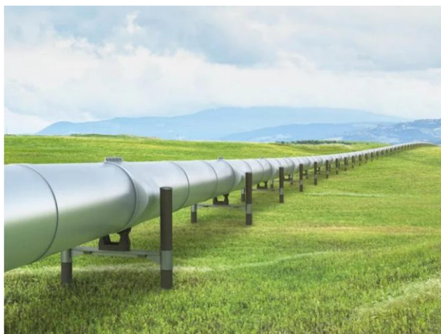
Figura 5: L'oleodotto Keystone Pipeline in Nord America
