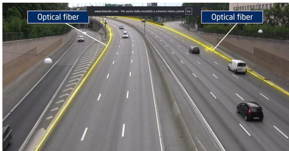
Figura 22: La fibra un sistema sensoriale distribuito
